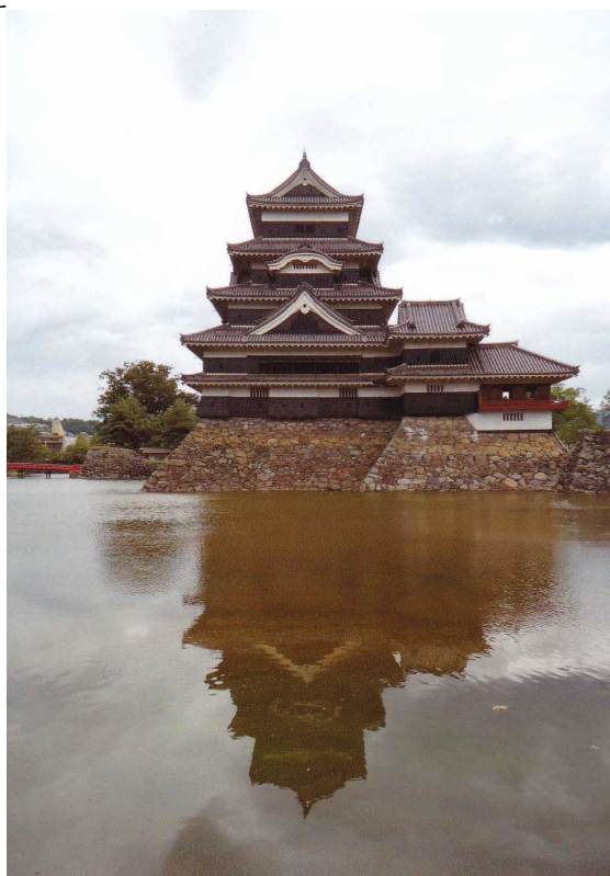
松本城：平城で、5層6階の天守に小天守と櫓が直結している。防御のために窓が少なく、矢狭間が各所にあり、石落しがある。石垣の傾斜が緩く、安定感があります。
