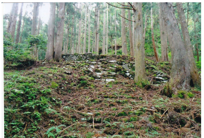
崩壊した堂塔石垣
