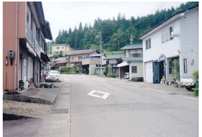
鮎走旧国道沿線住宅(令和7・6・9撮影)
