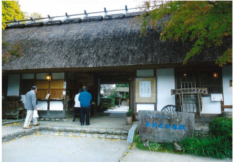
三州足助屋敷入り口の茅葺きの長屋門
